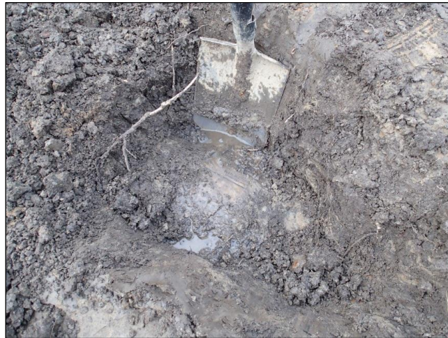
Moderni putki koekaistan sekoittuneen maa-aineksen kohdalla.
