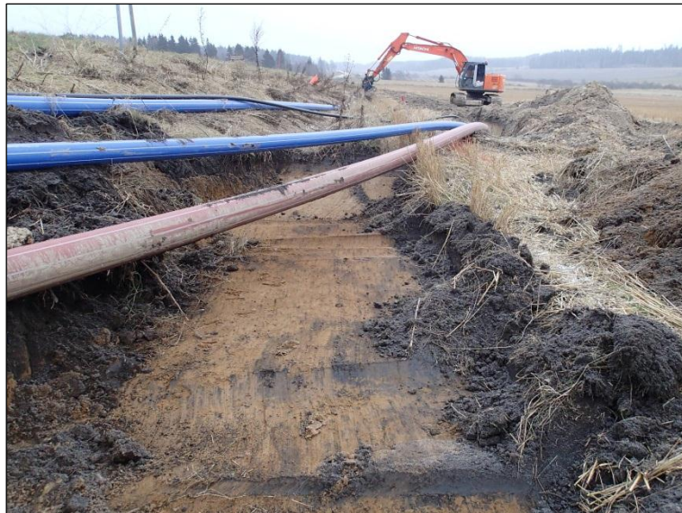
Koekaistan alkupää (kaakkoispää) taustalla jo kaivettua viemäriä hieman kauempana tien reunaan. Kuva luoteesta.
