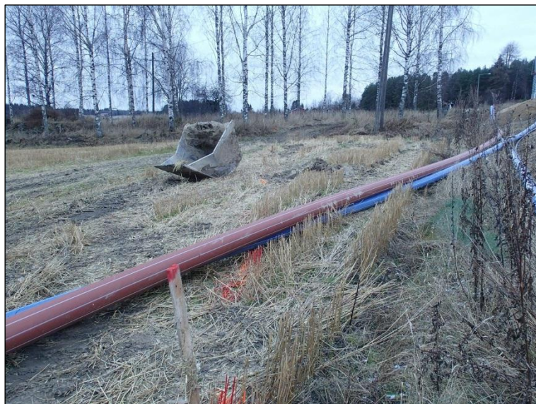
Vesihuoltolinjan kaivamatonta osuutta muinaisjäännösalueella ennen arkeologista valvontaa.
