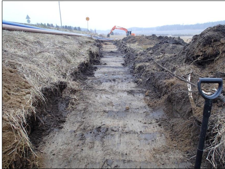
Koekaista kaivettuna lähelle pellolle menevää pistotietä. Kuva luoteesta.
