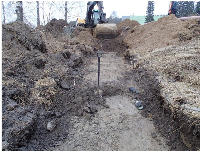
Koekaista kaivettuna pellolle menevän pistotien kohdalle. Kuva itäkaakosta.
